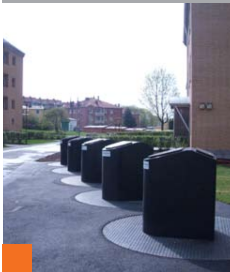
Silo sub er hele beholderen på 5000 liter under bakken.
